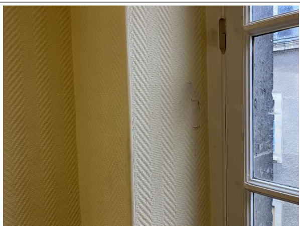
Prélèvement - P46 : Patio 1 / R+1 / Façade Ouest / Dégagement - Enduit- (Absence d'amiante)
