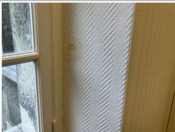
Prélèvement - P40 : Patio 1 / R+1 / Façade Ouest / Local Police - Enduit- (Présence d'amiante)
