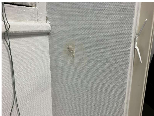
Prélèvement - P16 : Patio 1 / R+1 / Façade Est / Local 139 - Enduit- (Présence d'amiante)
