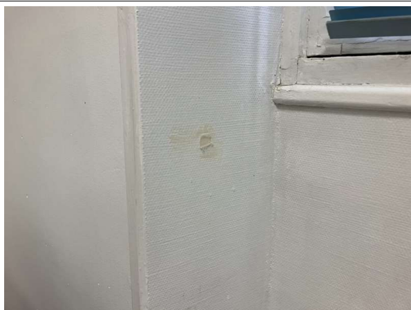
Prélèvement - P18 : Patio 1 / R+1 / Façade Est / Local 139 - Enduit- (Présence d'amiante)
