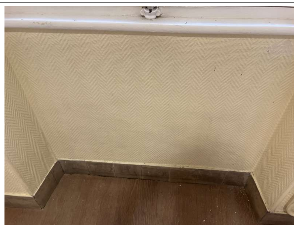
Prélèvement - P45 : Patio 1 / R+1 / Façade Ouest / Dégagement - Enduit- (Présence d'amiante)
