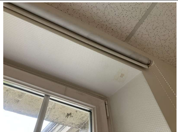
Prélèvement - P31 : Patio 1 / R+1 / Façade Sud / Local 235 - Enduit- (Absence d'amiante)
