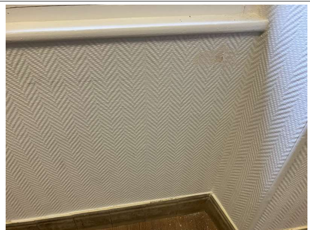
Prélèvement - P41 : Patio 1 / R+1 / Façade Ouest / Local Police - Enduit- (Absence d'amiante)
