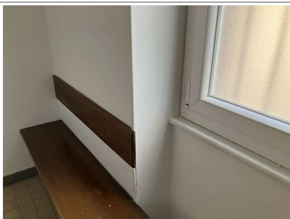
Prélèvement - P58 : Patio 1 / R+1 / Façade Ouest / Local Détenu - Enduit- (Absence d'amiante)
