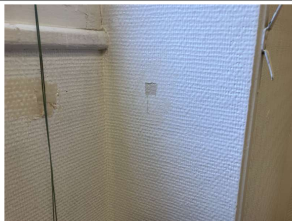
Prélèvement - P19 : Patio 1 / R+1 / Façade Est / Local 140 - Enduit- (Présence d'amiante)
