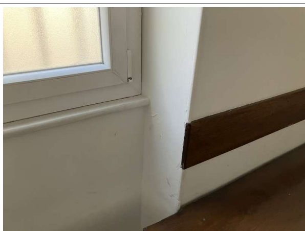
Prélèvement - P56 : Patio 1 / R+1 / Façade Ouest / Local Détenu - Enduit- (Absence d'amiante)
