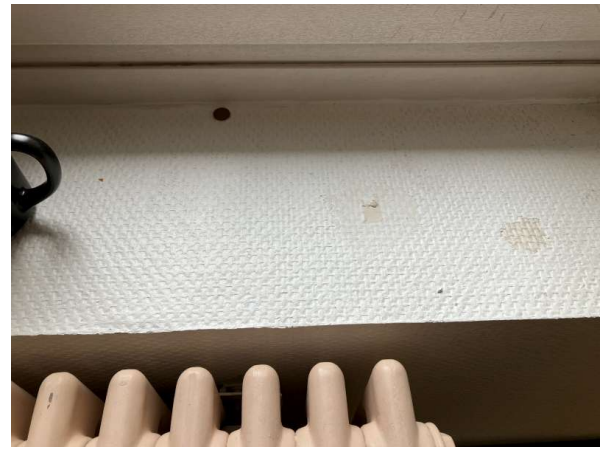
Prélèvement - P29 : Patio 1 / R+1 / Façade Sud / Local 235 - Enduit- (Absence d'amiante)
