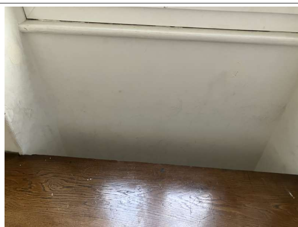
Prélèvement - P53 : Patio 1 / R+1 / Façade Ouest / Local Détenue - Enduit- (Absence d'amiante)
