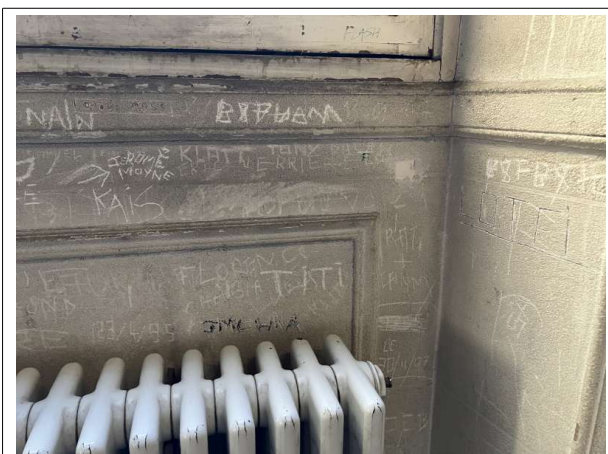
Prélèvement - P226 : Patio 1 / R+1 / Façade Nord / Circulation - Parement- (Absence d'amiante)
