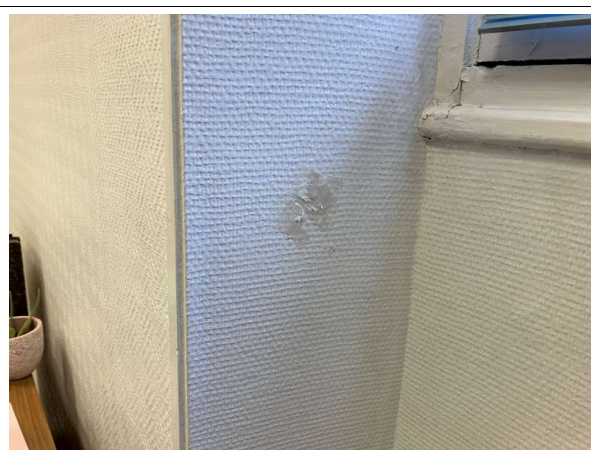
Prélèvement - P21 : Patio 1 / R+1 / Façade Est / Local 140 - Enduit- (Présence d'amiante)
