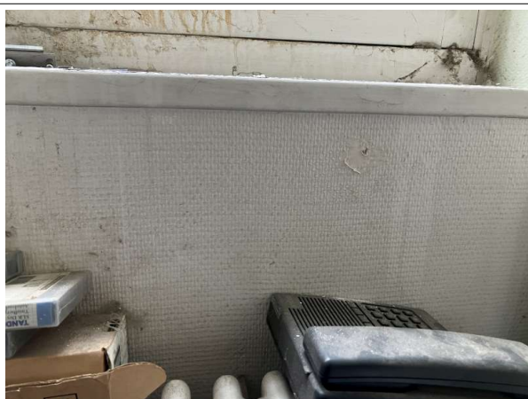
Prélèvement - P26 : Patio 1 / R+1 / Façade Est / Local 142 - Enduit- (Absence d'amiante)
