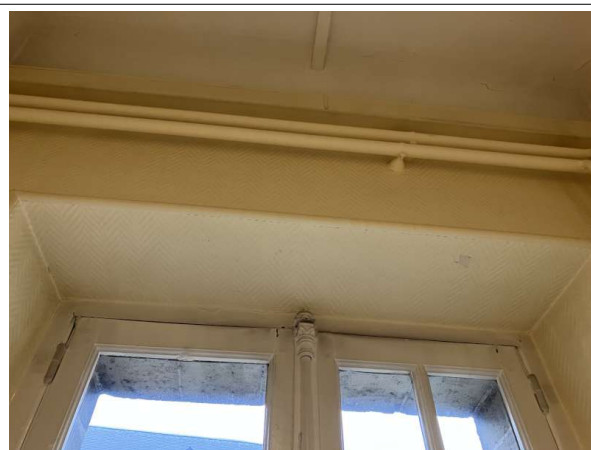
Prélèvement - P47 : Patio 1 / R+1 / Façade Ouest / Dégagement - Enduit- (Absence d'amiante)
